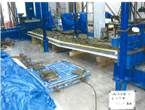
写真5 試験体の状況（最大荷重時） 最大荷重=3394 N/m 2 ・スタッドの脱落
