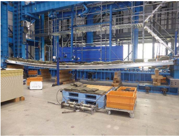
写真 1 試験体の状況（所定荷重時） ・全景
