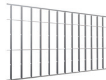
振れ止めの取付け
