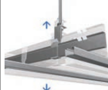
天井高、水平などを調整し、ハンガを固定する
