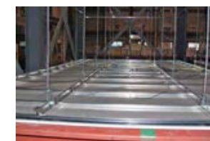
No.5 被害無し：クリップの損傷無し
