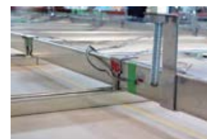
No.4 被害無し：耐震クリップの状態
